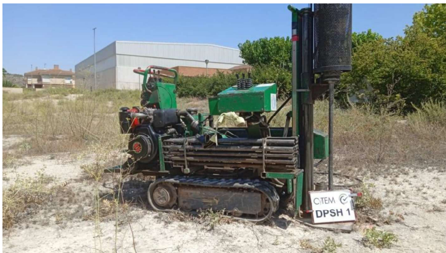
Fotografía 4: Vista del emplazamiento de la DPSH-1.
