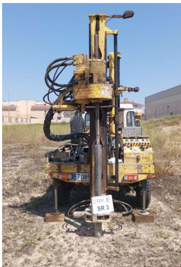
Fotografía 3: Vista del emplazamiento del sondeo SR-3.
