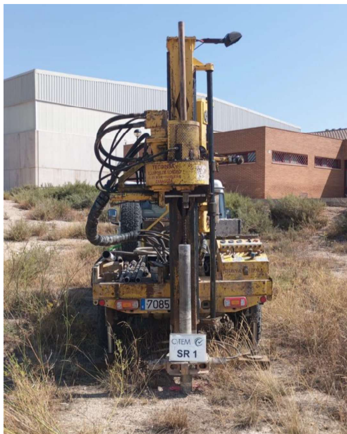
Fotografía 1: Vista del emplazamiento del sondeo SR-1.
