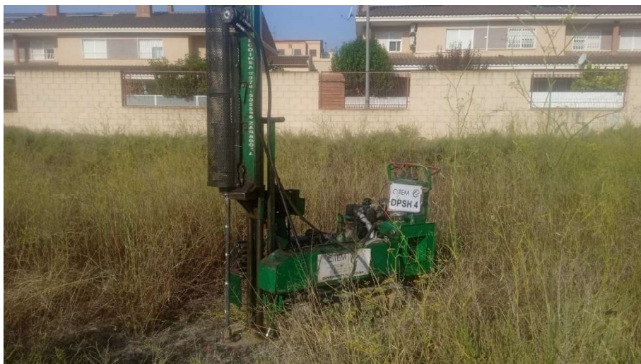
Fotografía 7: Vista del emplazamiento de la DPSH-4.
