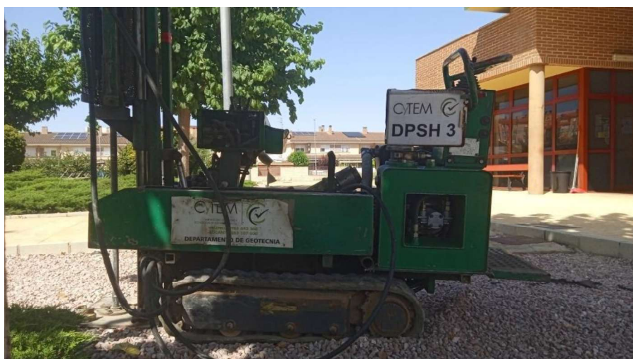
Fotografía 6: Vista del emplazamiento de la DPSH-3.
