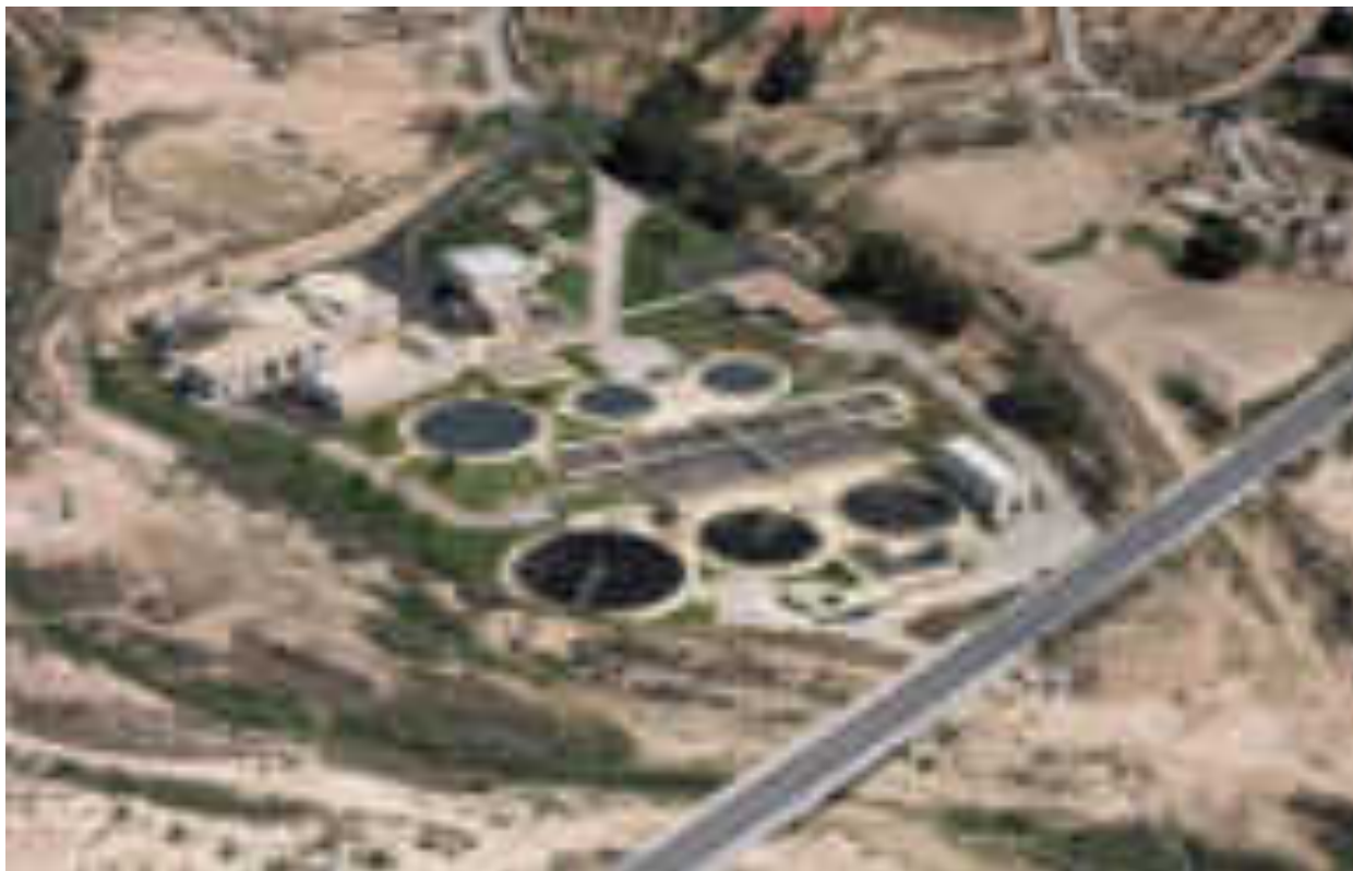
Figura 23 Vista en perspectiva de la EDAR Valle del Vinalopó. Fuente: Valle del Vinalopó | Epsar (gva.es)
