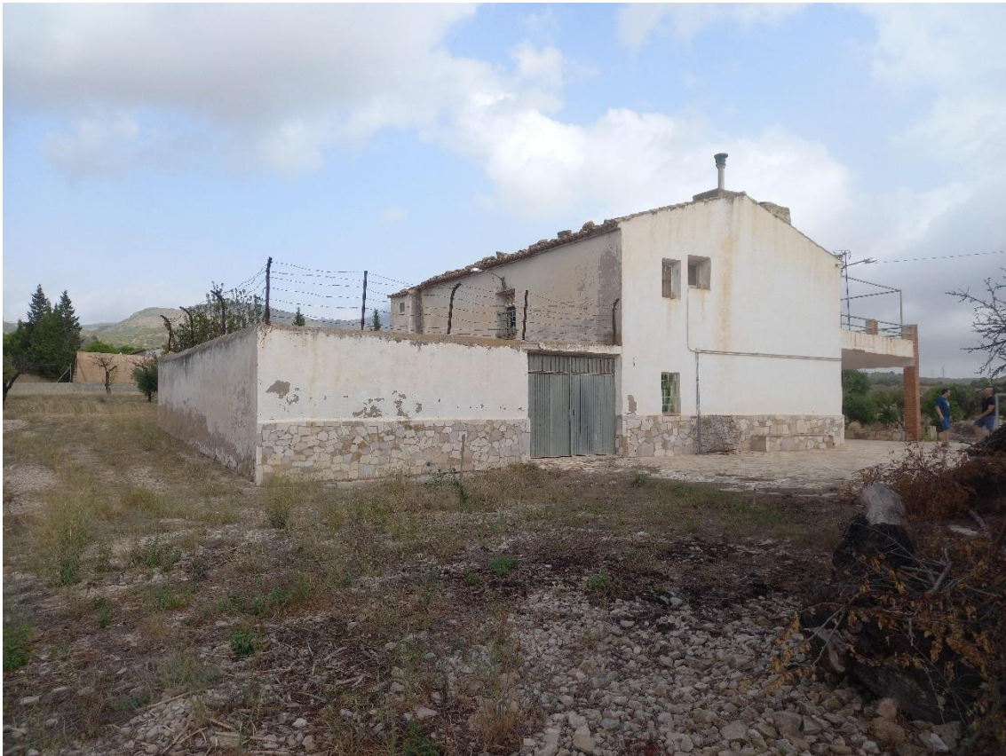
VIVIENDA EXISTENTE DESDE EL INTERIOR DE LA PARCELA – VISTA OESTE
