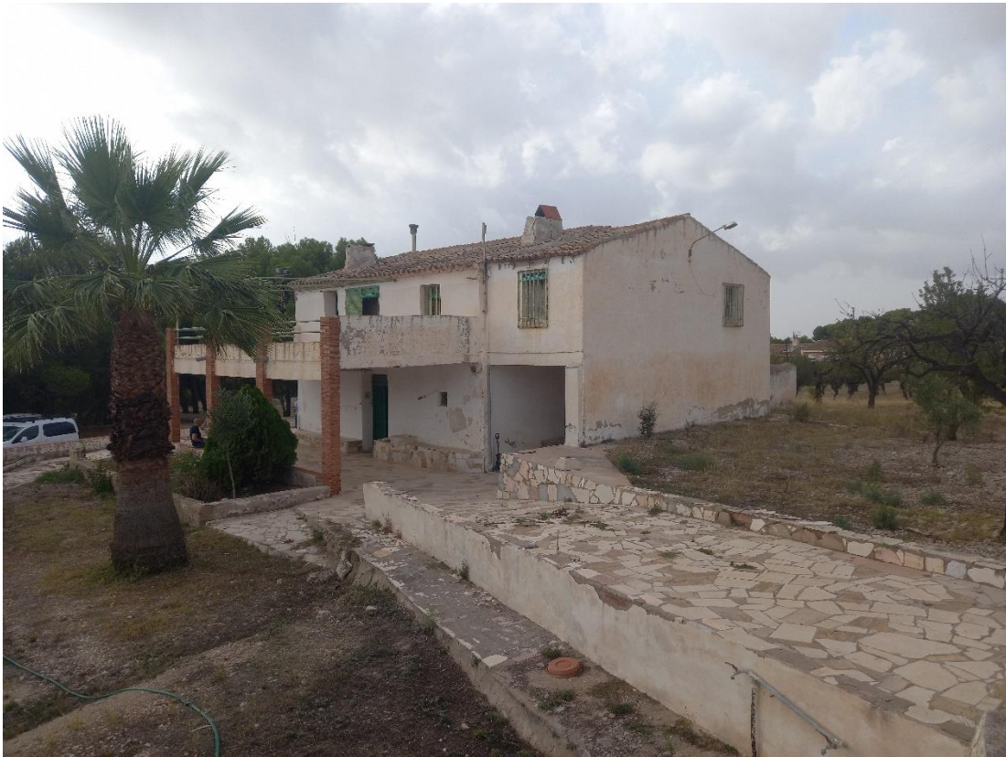
VIVIENDA EXISTENTE DESDE EL INTERIOR DE LA PARCELA – VISTA SURESTE
